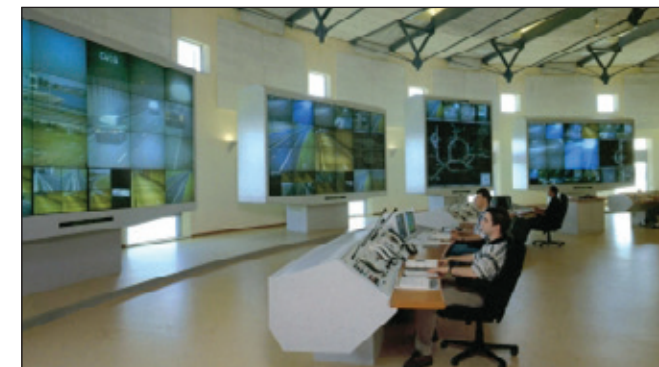
Koppeling met de verkeerscentrale
